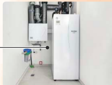
Ecodan Cylinder, vodna enota toplotne črpalke z integriranim rezervoarjem sanitarne vode in centralizirana prezračevalna naprava z rekuperacijo toplote Loosnay VL-CZPVU
